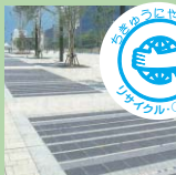
再生材料を使用したタイルやブロックを利用した富山駅前の舗道。
