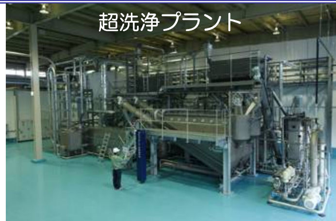
キャップ・ラベルの除去、アルカリ洗浄
